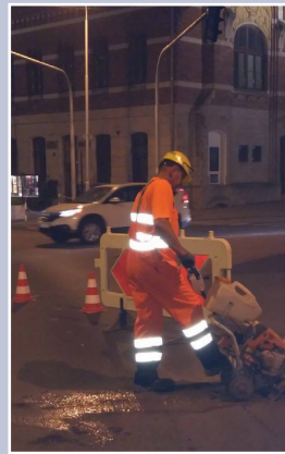
Uzupełnianie ubytków w drogach masą bitumiczną
