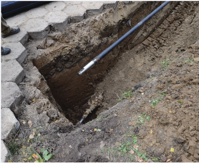
Przewiert pod rzeką San.
